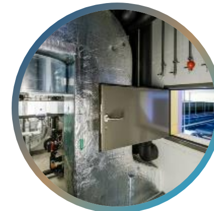
Valsana Hotel Arosa: Nutzung Abwärme durch Eisspeicher
