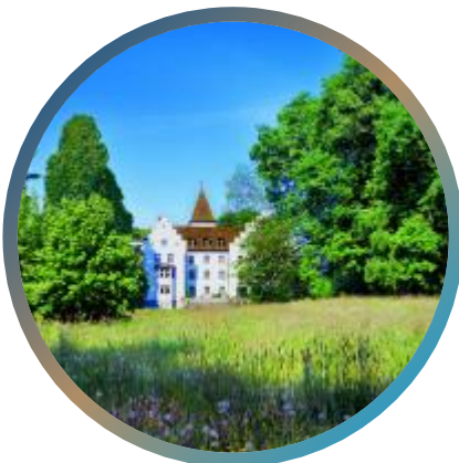
Schloss Wartegg: Parkanlage für Insekten und Magerstandort- pflanzen, eigenes Flusskraftwerk, 100% Ökostrom
